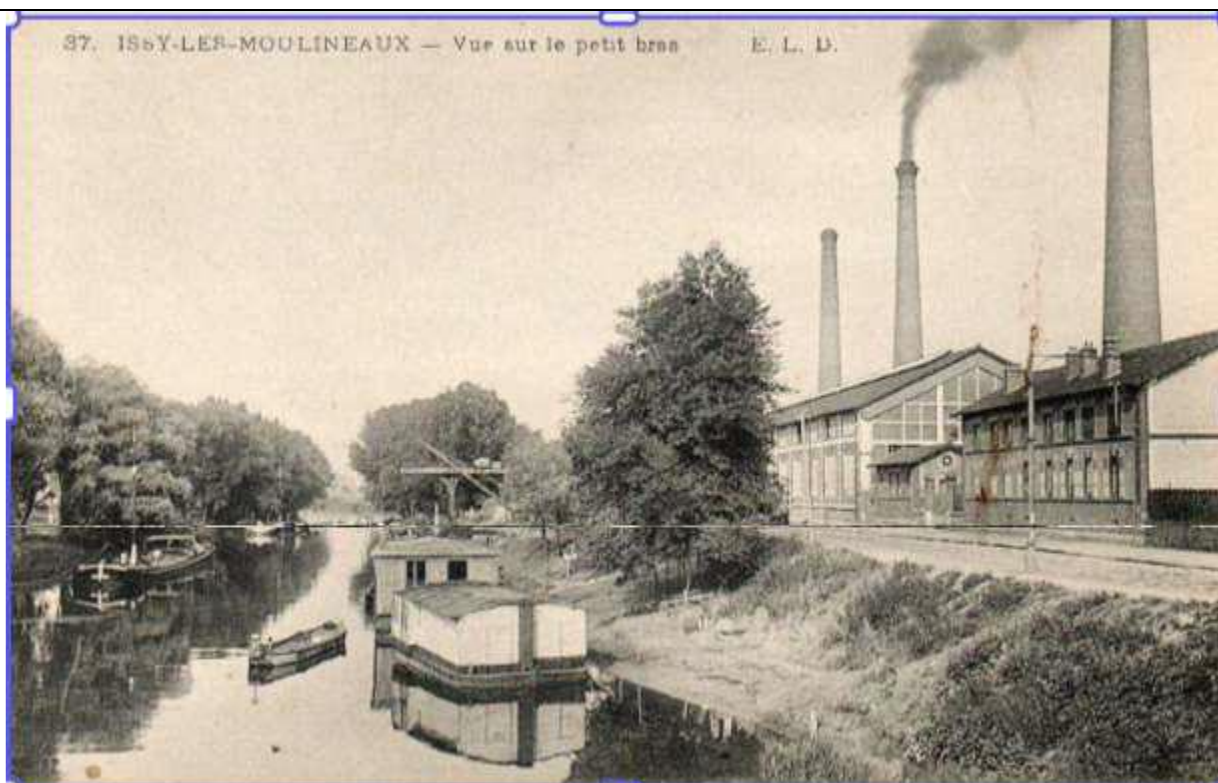
Les ateliers à droite sont reconvertis en bureaux
