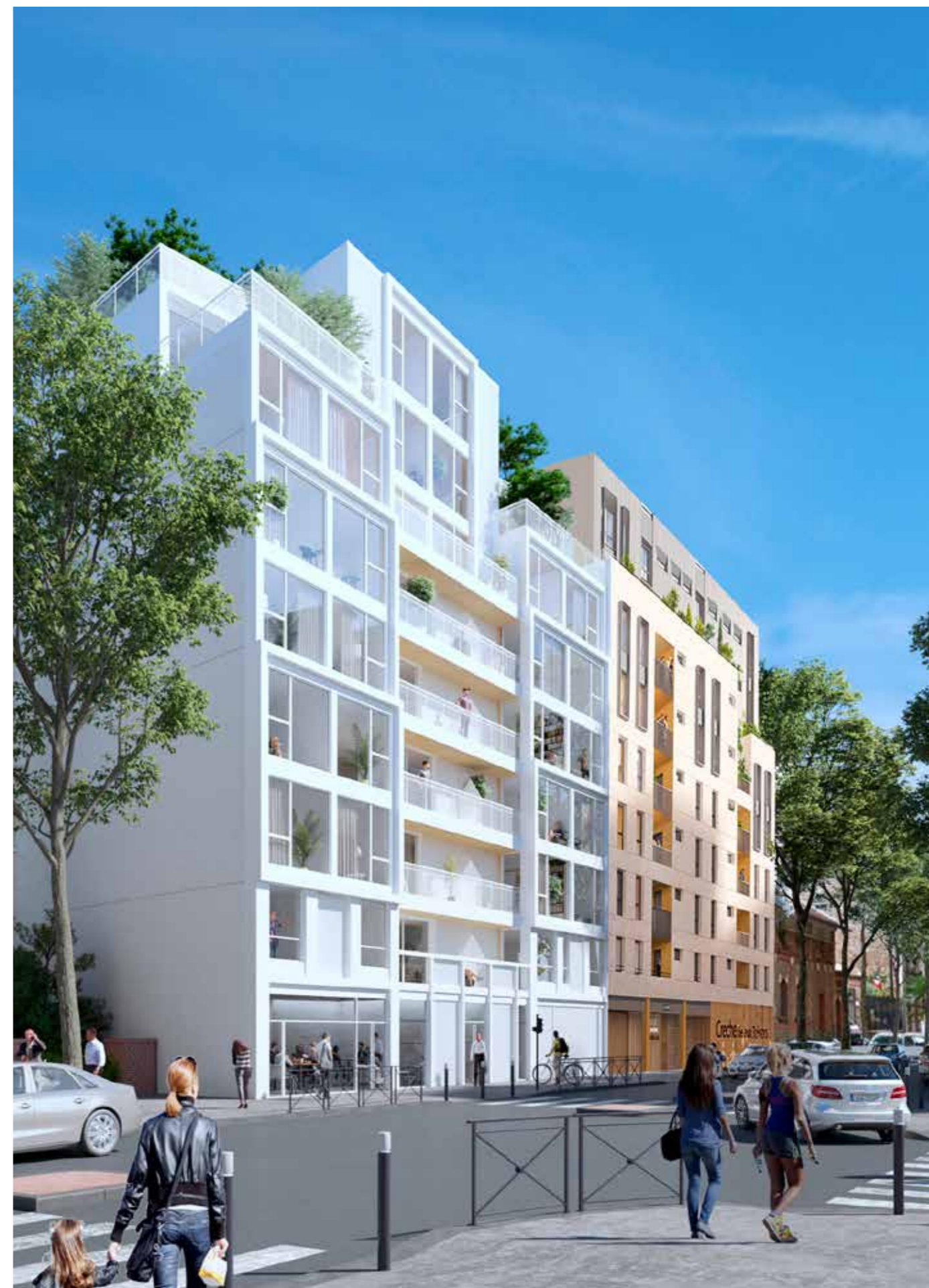
HOYA – Façade côté avenue de Verdun
