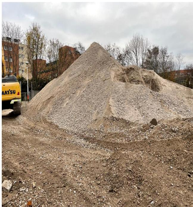
Lors de la déconstruction de l'immeuble du 51-55 rue Aristide Briand, **l'entreprise a conservé le béton démolé dans le but d'obtenir un béton concassé finement.**
