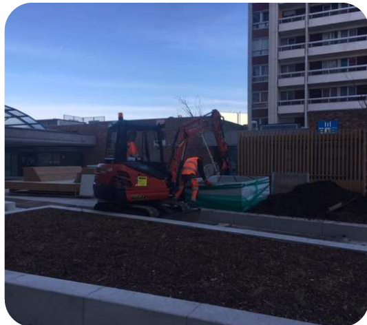
Pose d'un bac jardinière destiné à recevoir un arbre
