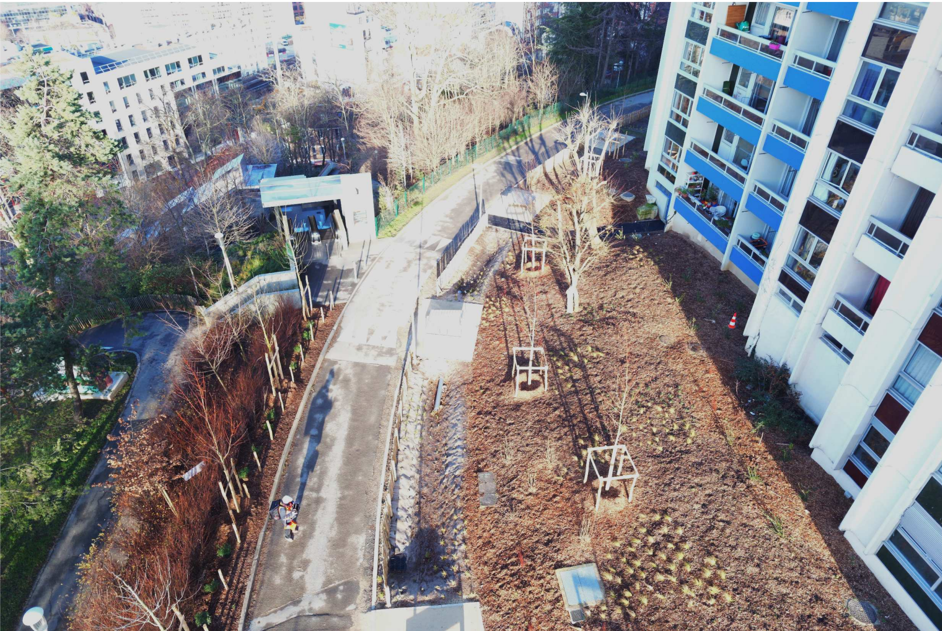
Pose des derniers revêtements
